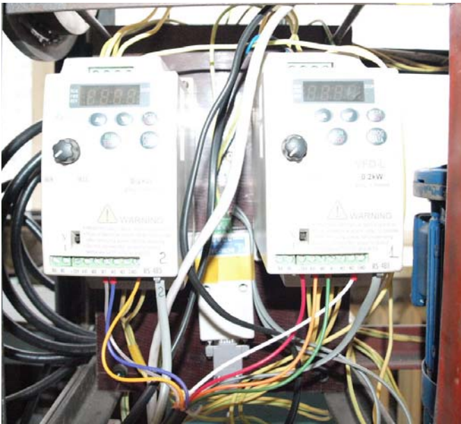
Рисунок 5 Частотные преобразователи марки Delta VFD-L
